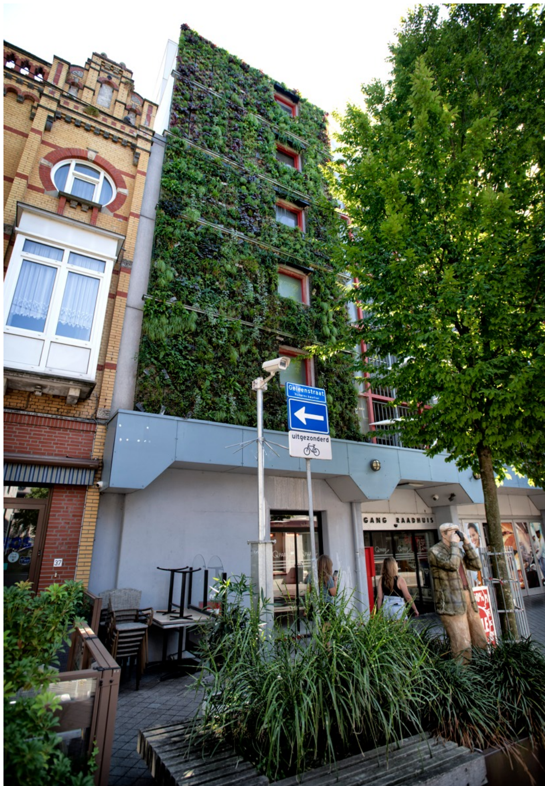
De kale wand van de parkeergarage in de Geleenstraat is opnieuw vergroend. FOTO BAS QUAEVLIËG
